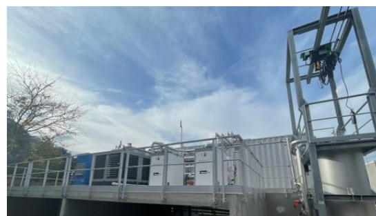
ÉPURATEUR DE BIOGAZ
